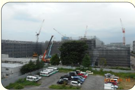
外壁も少しずつ作られています。
